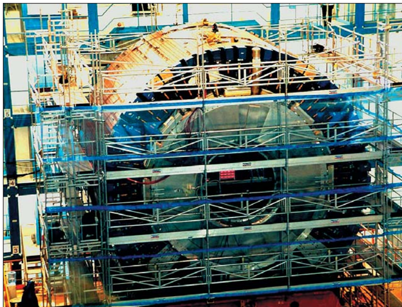
В экспериментальном зале установки ATLAS монтируется центральный калориметр.
